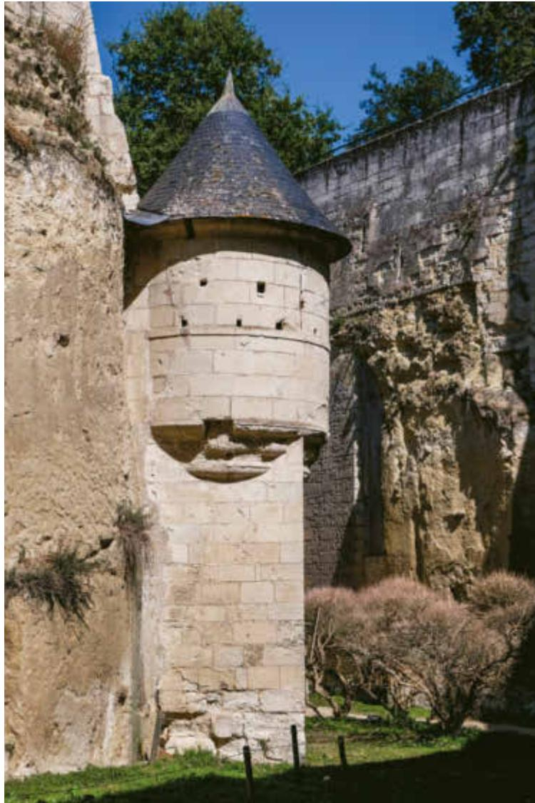
Des bouches à feu sont réparties à différents niveaux et disposées à la base du mur de façon à protéger le fond des douves.
