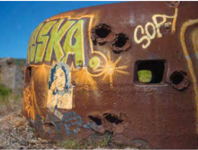
Une cloche blindée au fort de la Varde à Saint-Malo.
