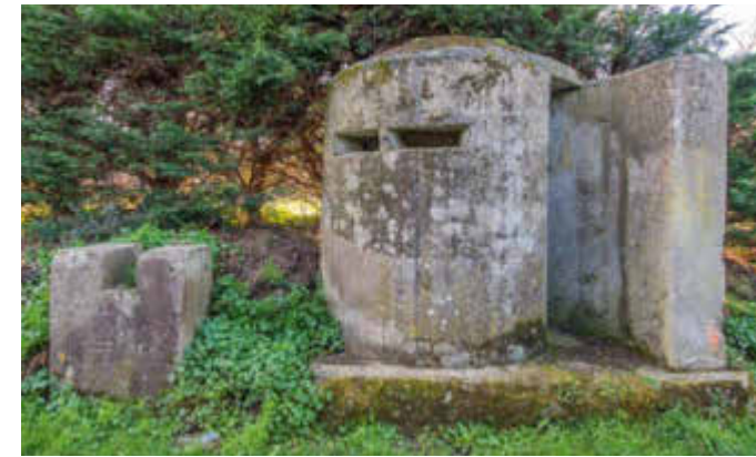
Une guérite en béton indique l'entrée de l'ancien camp du Wern à Paimpol.
