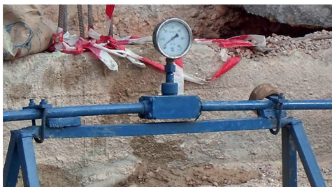
Photo 11.03-3. Manomètre de contrôle de pression et micropieu achevé
