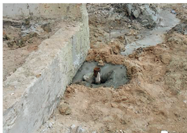
Photo 11.03-3. Manomètre de contrôle de pression et micropieu achevé
