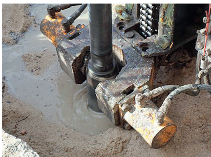
Photo 11.03-2. Opération de forage et tube d'injection
